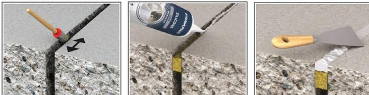
1. Поверхность, на которой будет применяться силикон, должна быть сухой, чистой, свободной от пыли, жира, масла, ржавчины, остатков старого уплотнителя и других материалов, ухудшающих сцепление с поверхностью.
